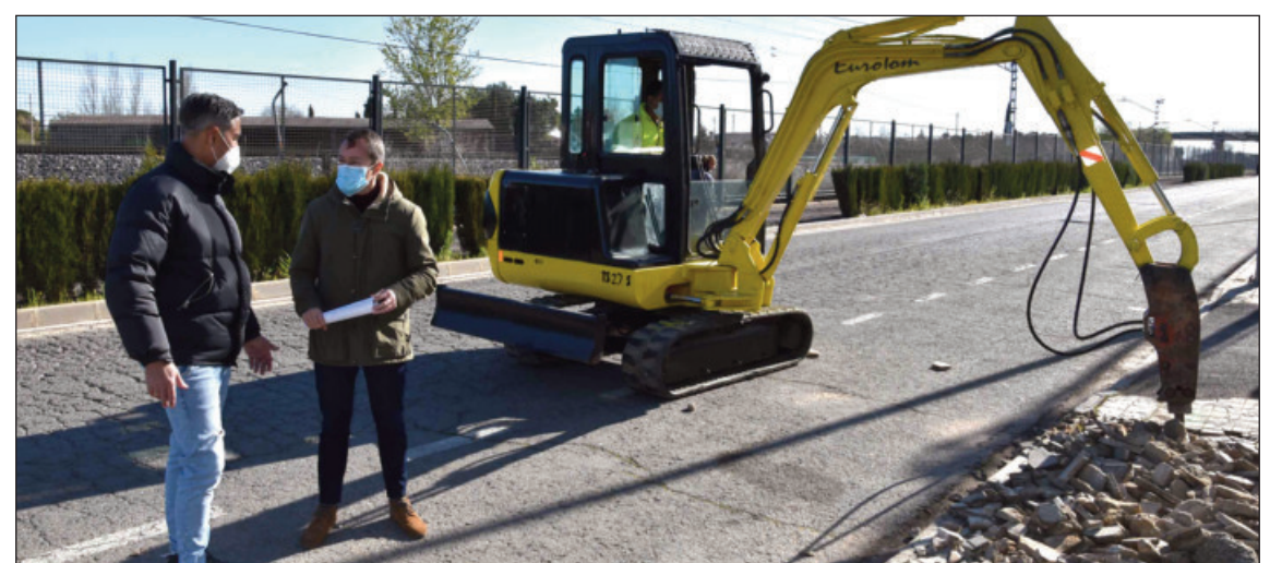
Las obras consisten en pavimentación y reparación de calzadas y acerados
