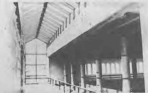
Las vidrieras de la galería aumentan la luz del salón y la biblioteca.
