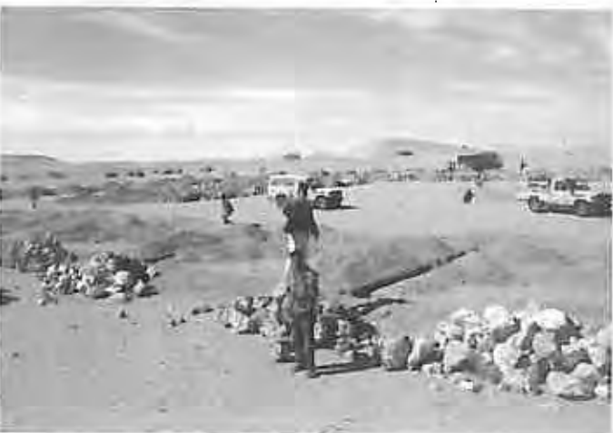
La construcción de un colegio ya está en marcha
