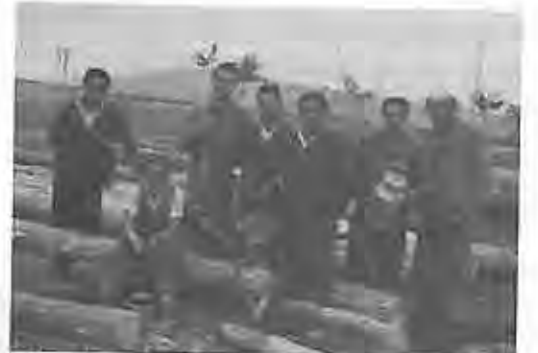
2. De Eusebio Nieto son las tres siguientes fotos. En esta lo vemos con otros compañeros en una curiosa tarea: inyectando postes para el tendido eléctrico. Es en Ciudad Real, a finales de los 50.
