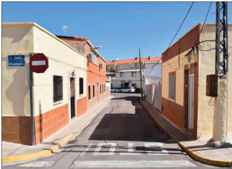
Tramo de la calle Calvario que renovará la red de agua
