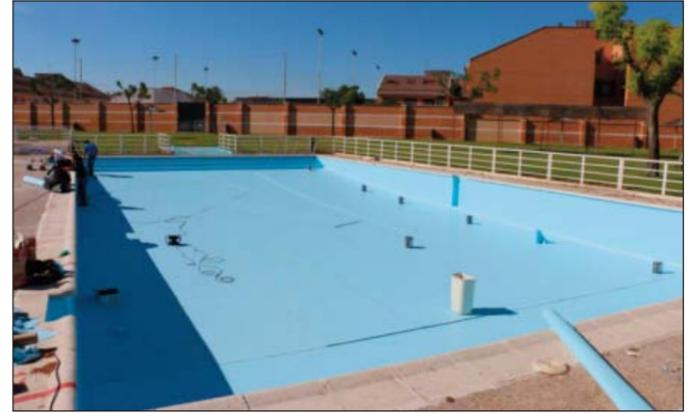
Las piscinas municipales, la Olímpica, y la de 25 metros, solucionan las pérdidas de agua que ambos vasos tenían con la colocación de una lamina armada vinílica.
