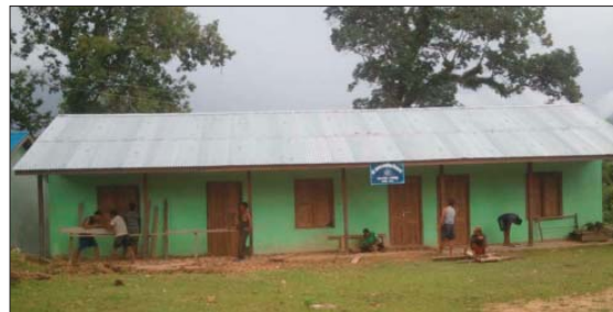
Escuela de Ramechap, una de las tres construidas en este proyecto
