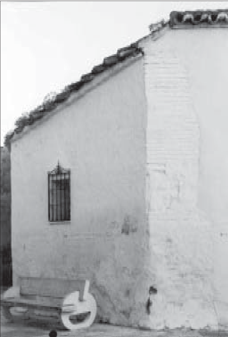
Detalle de una de las esquinas de la cabecera de la ermita, donde se observa los materiales empleados a base de mortero, argamasa y ladrillería reforzando las esquinas
