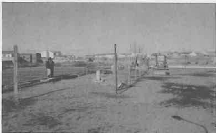
Las obras ya se iniciaron en la calle Ancha
