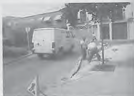
Operarios trabajando en la ampliación de la calzada en la plaza para facilitar el paso del bus
