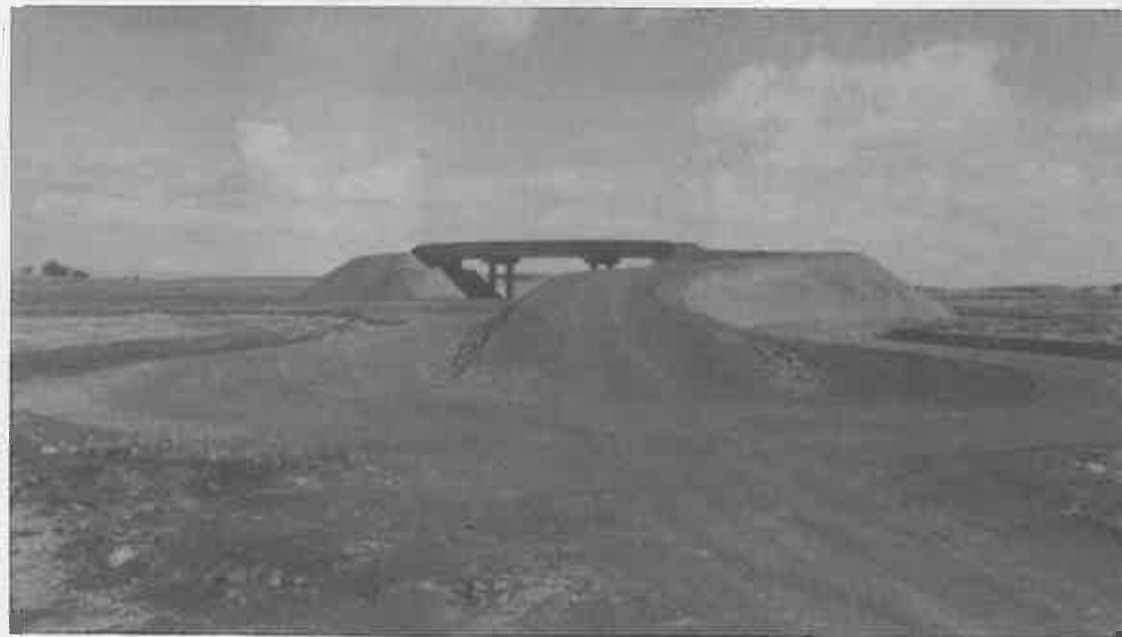
Los accesos a los puentes serán mejorados
